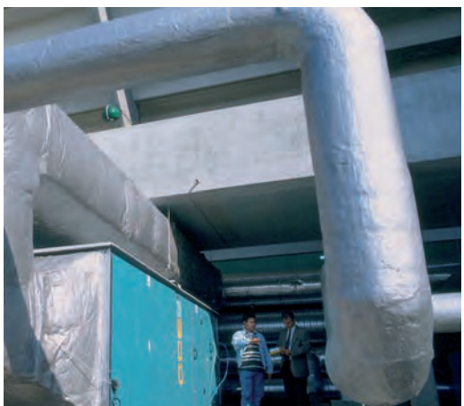
Насосные агрегаты в системах управления зданиями
