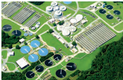
Водоподготовка, водоснабжение и водоотведение
